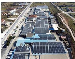
του σταθμού χρησιμοποιήθηκαν 3.675 φωτοβολταϊκά πλαίσια της κατασκευάστριας εταιρείας JA Solar ισχύος 585W, 10 μετατροπείς της κατασκευάστριας εταιρείας Huawei (μοντέλο SUN2000-215KTL-H0) και βάσεις στήριξης Μεταλουμίν. Η τοποθέτηση ήταν συνδυαστική και περιλάμβανε διαφορετικές επιφάνειες της στέγης του εργοστασίου, όπως μεταλλικές στέγες, στέγες από μπετό και τα διαθέσιμα δώματα. Ο σταθμός συνδέθηκε με απόλυτη επιτυχία στη μέση τάση του εργοστα-
